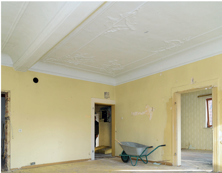
Trotz Veränderungen in der Nachkriegszeit ist im Inneren des Gebäudes noch wertvolle historische Bausubstanz wie etwa eine Stuckdecke erhalten.
