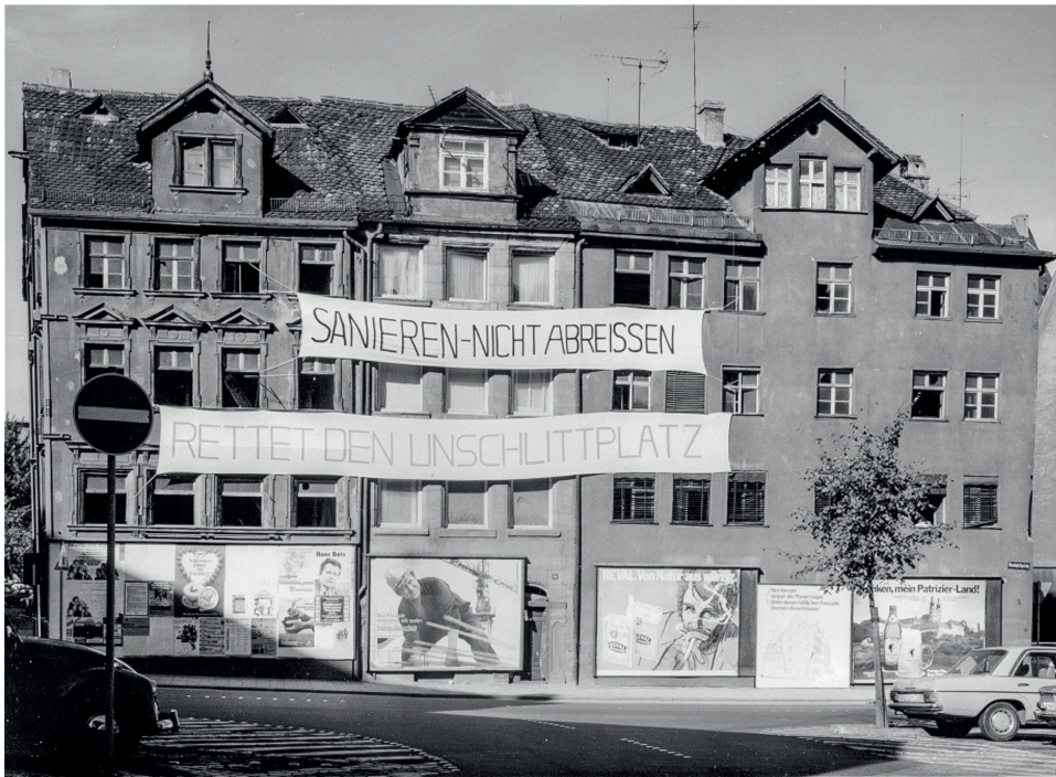
1. Erfolgreiche Bürgerinitiative (Altstadtfreunde e. V.): Nürnberg, Unschlitzplatz 8–12, Zustand vor der Instandsetzung, 1976
