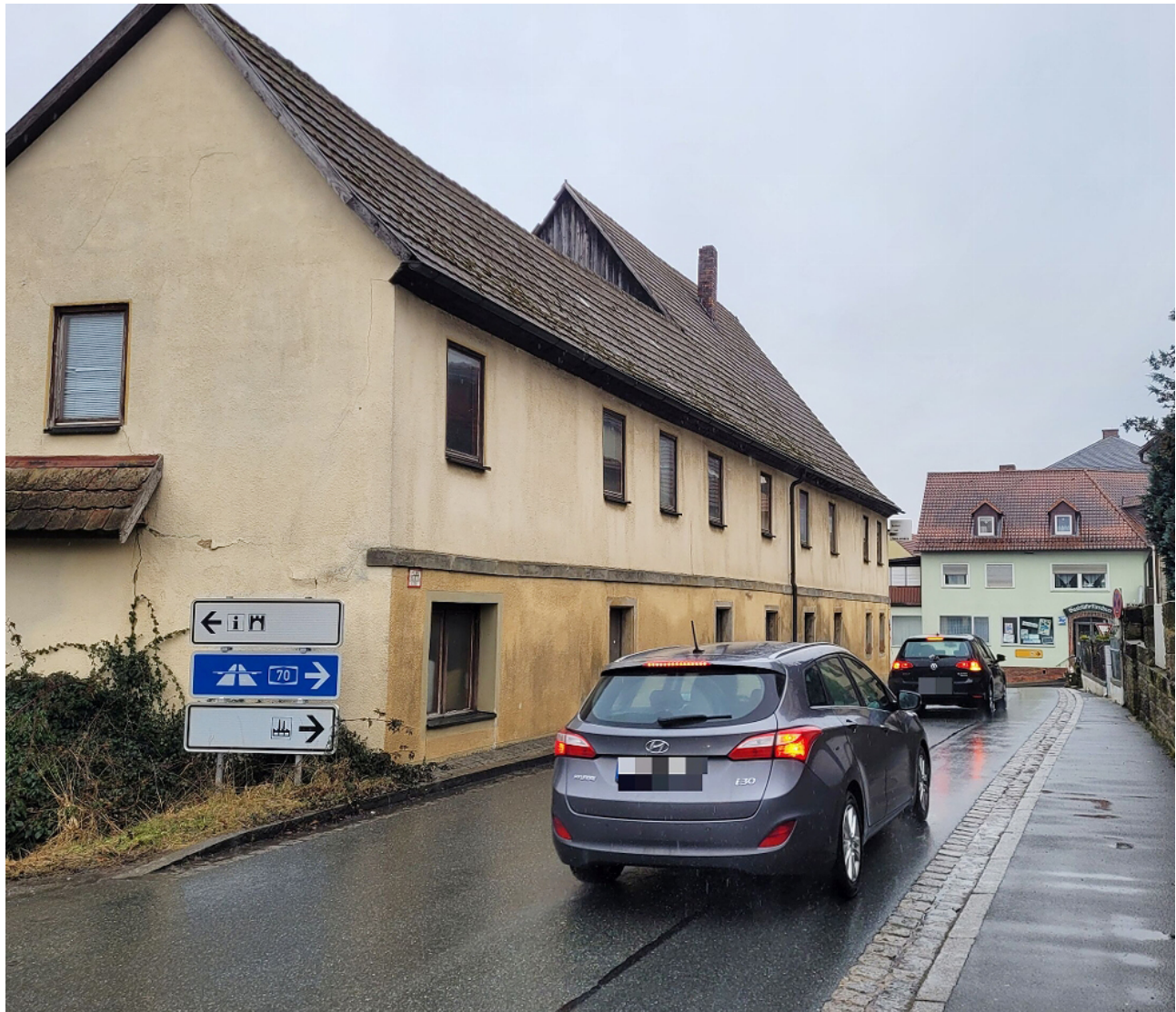
Das ist das Gebäude in der Kulmbacher Straße, dessen Abriss zur Diskussion stand.
