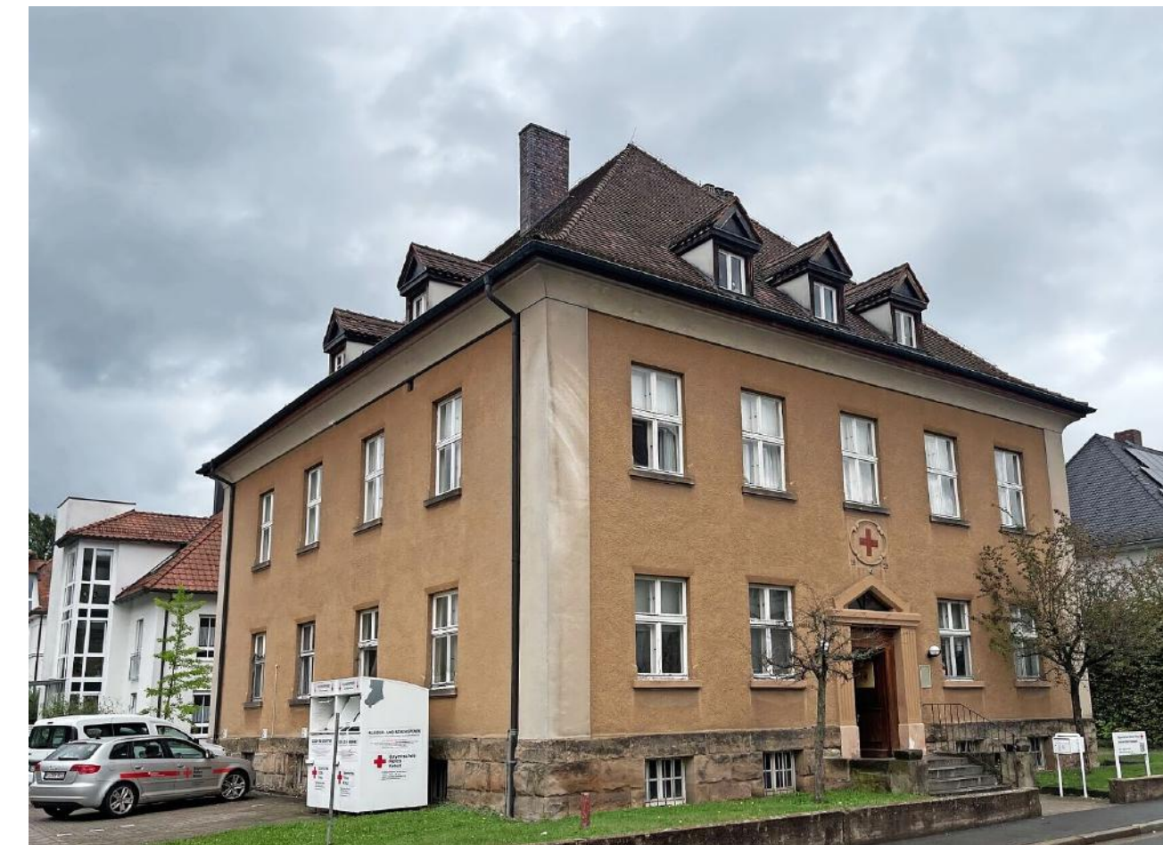
Das BRK will in der Flessastraße eine Kita bauen und dafür das alte Verwaltungsgebäude abreißen – das sorgt für Kritik. Foto: Jürgen Gärtner
