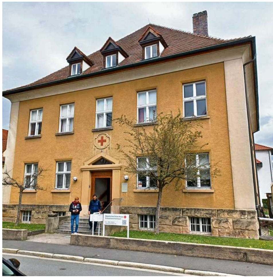
Das ehemalige Verwaltungsgebäude des BRK-Kreisverbands in Kulmbach ist derzeit noch Unterkunft für etwa 25 Flüchtlinge. Schon bald soll das Gebäude abgerissen werden und an seiner Stelle eine Kita mit 53 Plätzen entstehen.
