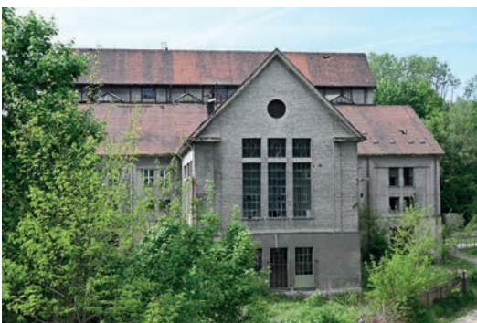
Dem schleichenden Verfall überlassen: Die ehemalige elektrische Zentrale Foto: Annegret Bähnisch
