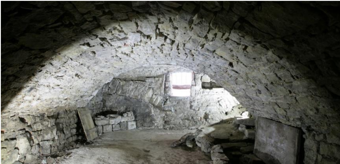
Gewölbekeller mit Blick in Richtung Judengasse, hinten rechts der Zugang vom EG, vorne rechts die Mikwe (Holzdeckel)
